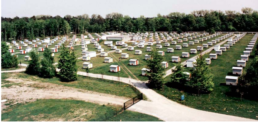
Abbildung 3.27: Das KASCADE-Experiment im Forschungszentrum Karlsruhe. Erkennbar sind neben den einzelnen Hütten des Detektorfelds auch der in der Mitte gelegene Zentraldetektor.
